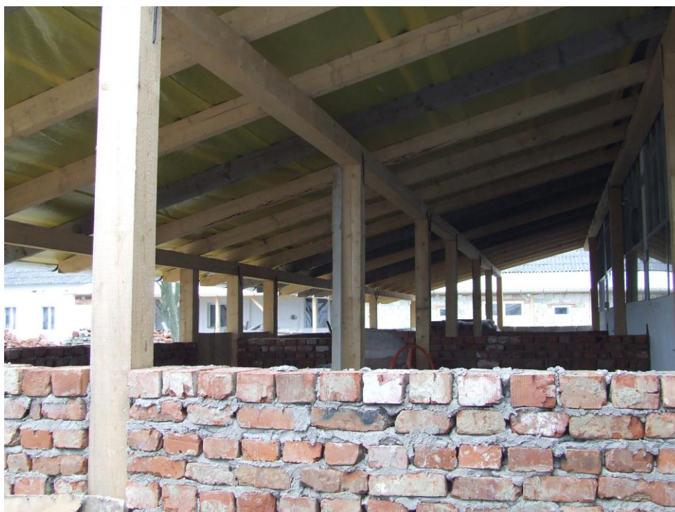
124. kép Új szárny épül a sertéstelepen (fotó: Kajner Péter)
